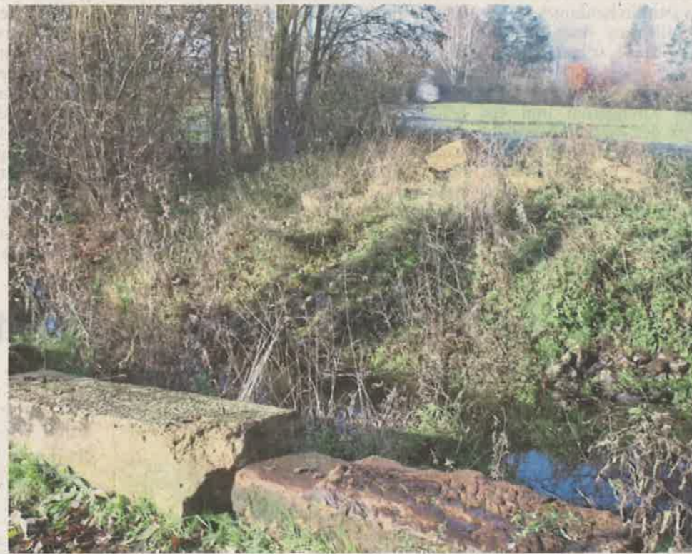
Hier war einst eine kleine Brücke über die Semme. Sie durfte nicht mehr sein – doch eine einfache Furt aus Steinen darf auch nicht so einfach sein.
